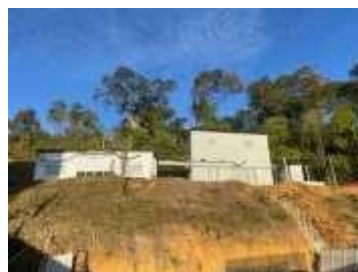
Subestação (ainda em construção)
